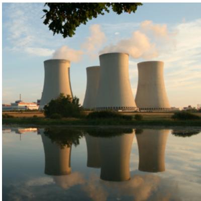
Jaderná elektrárna Temelín
