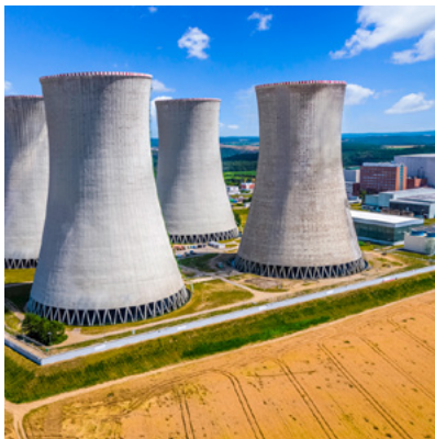
Jaderná elektrárna Dukovany
